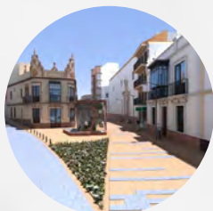
Calle La Mina (Alcalá de Guadaira)
