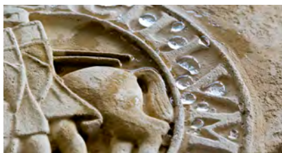
Rehabilitación, Conservación y Construcción
