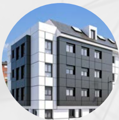
Urbanización Montecerrao (Oviedo)
