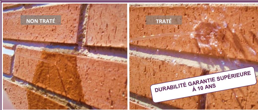
*Spécialement conçu pour le traitement de la brique de parement, du mortier, du béton préfabriqués et de tout type de substrats.*
