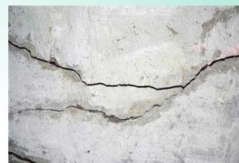
Attaques de gel-dégel
