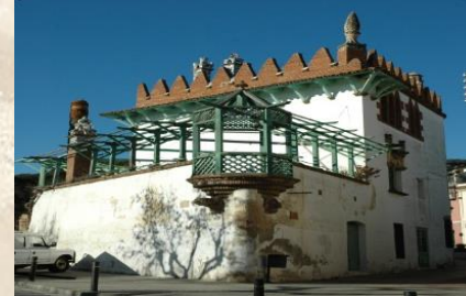
Casa Puig i Cadafach - Argentona (Barcelona - Spain)
