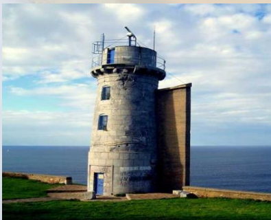
Cabo Matxitxako Lighthouse (Vizcaya - Spain)
