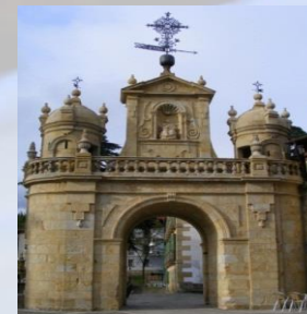
Sta Ana gate - Durango (Vizcaya - Spain)
