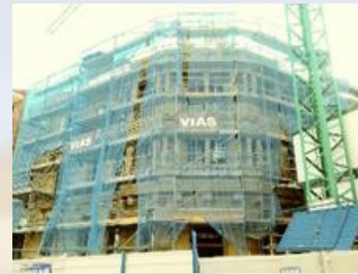
Mª Díez de Haro Building (Haro - Spain)
