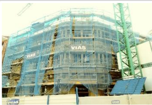
Mª Díez de Haro Building (La Rioja, Spain)
