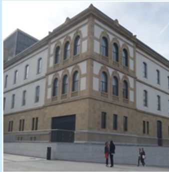
Edificio Tabacalera (San Sebastián)
