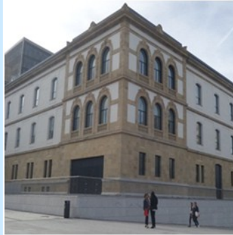
Tabacalera Building (San Sebastián)
