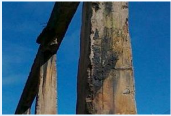
Carbonatación, corrosión por cloruros
