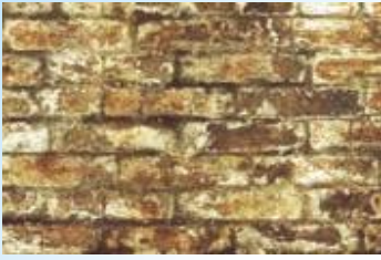
Contaminación: polvo, suciedad
