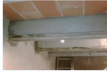
Presencia de humedad
